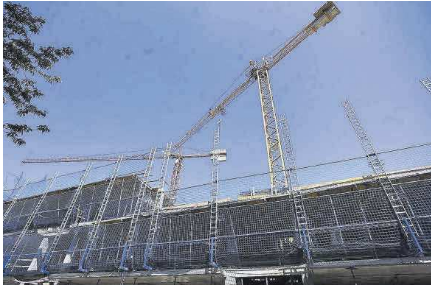
Promoció d'habitatges en construcció.
