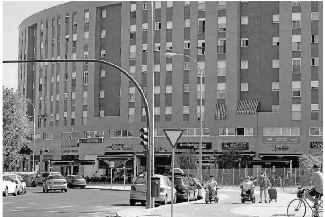
Un edificio de viviendas en Almería.
