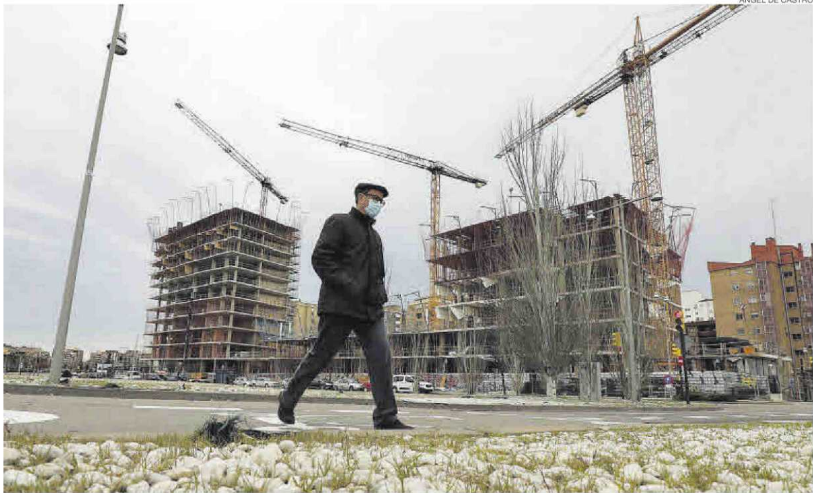
Obras de construcción de una vivienda nueva en el barrio zaragozano de La Almozara. ÁNGEL DE CASTRO
