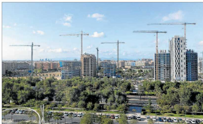
Viviendas en construcción en el barrio de Malilla, frente a La Fe. GERMÁN CABALLERO
