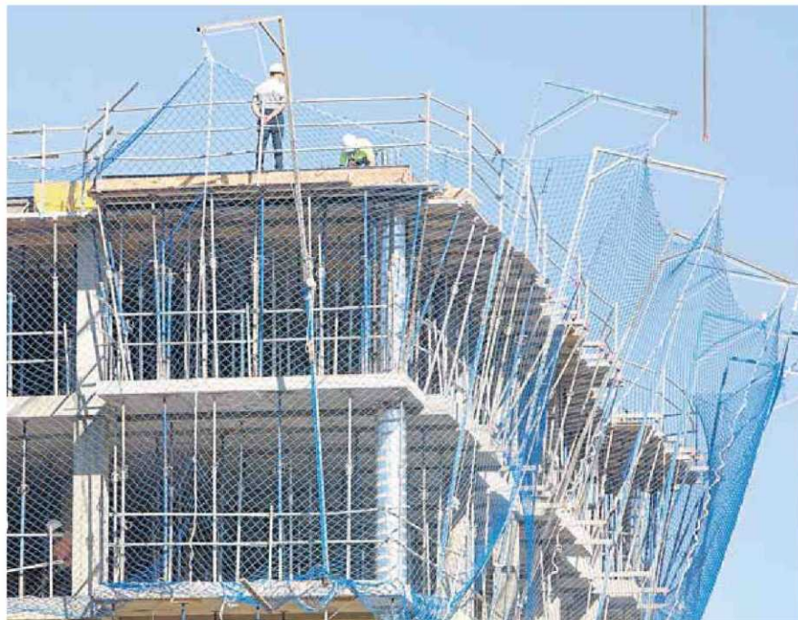
Obras y construcción de edificios en la ciudad de Valencia. :: DAMIÁN TORRES
