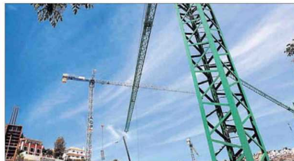
Obras de construcción de viviendas en Málaga. G. TORRES
