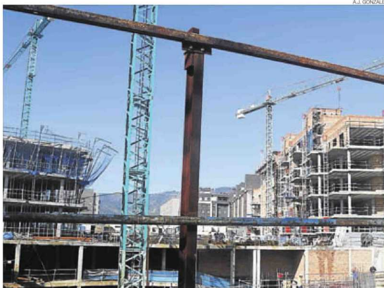
▶ Viviendas en construcción en el barrio del Cortijo del Cura.
