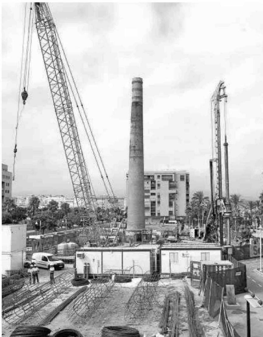
Vista de la obra que ya se ha iniciado en la calle Pacífico para un edificio de la Sareb de 54 viviendas.
