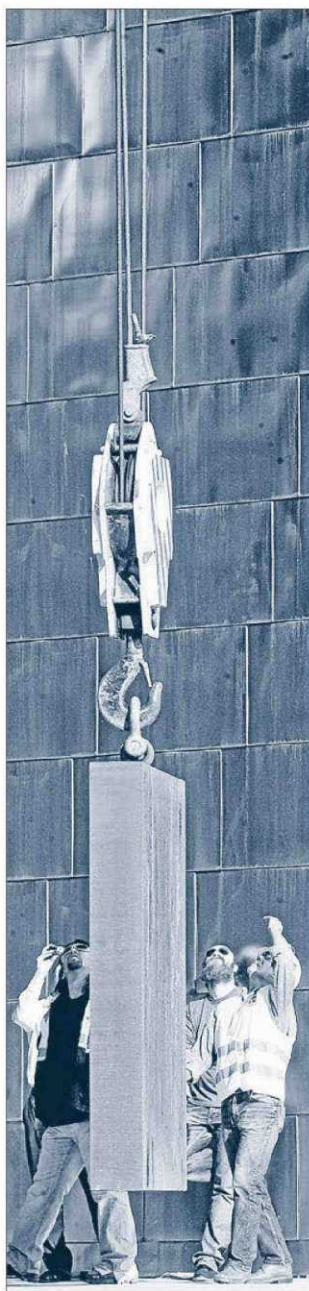
Operarios con una grúa. CARLOS GARCÍA POZO
