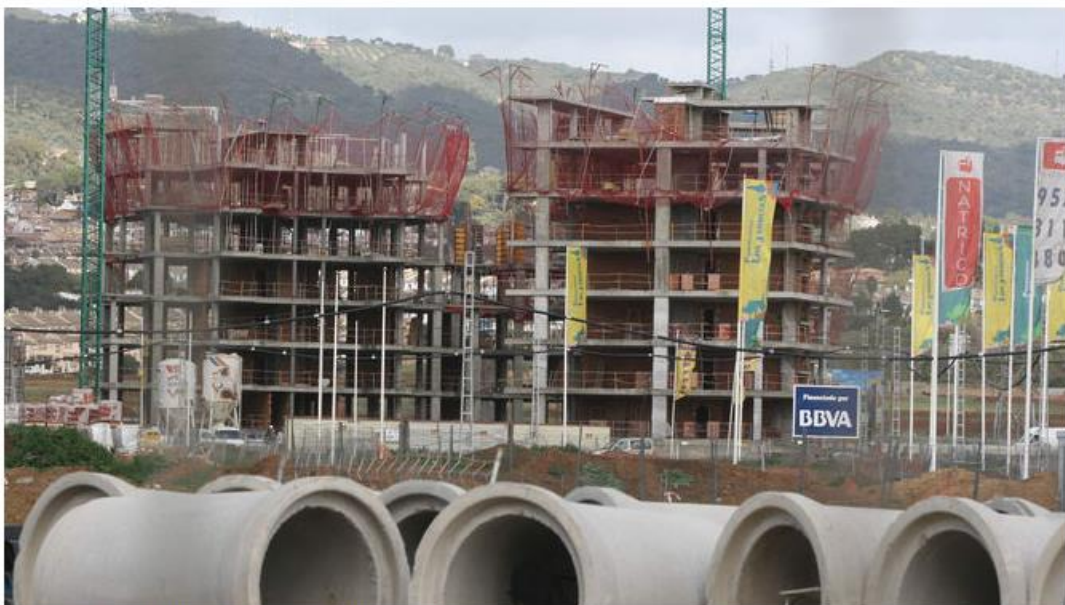
Un bloque de viviendas en construcción. / EL DÍA
