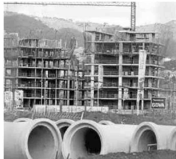
Un bloque de viviendas en construcción.
